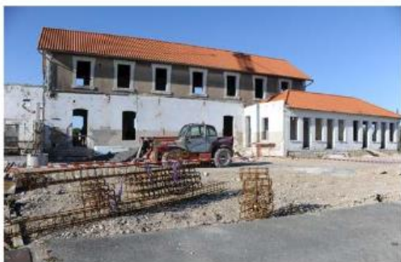
Une extension d'une surface de 800 m 2 sera construite à l'arrière du bâtiment (© Y.P.)
