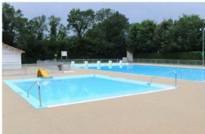
La piscine municipale vient d'être fermée plus tôt que prévu pour éviter une surcharge électrique et un incendie (© Y.P.)
