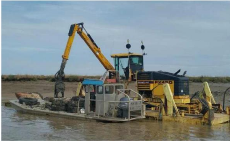
Restes de tables à huîtres, ancêtres pieux, ferraille, pneus de camions... sont retirés du lit de la Sèvre. RÉGIS GALLAIS
