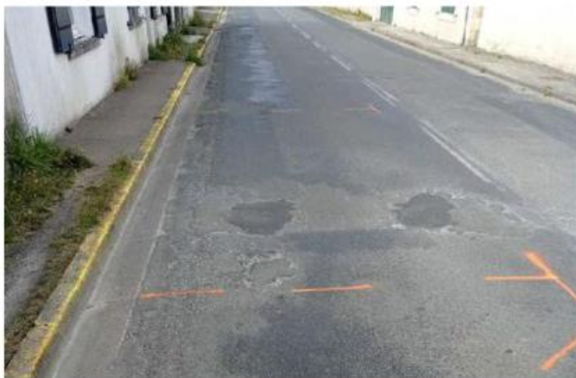
Le marquage au sol des futures chicanes de ralentissement a été effectué (© Y.P)
