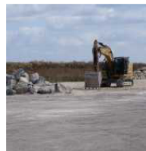
Les engins de chantier ont commencé à arriver. Y.P.
