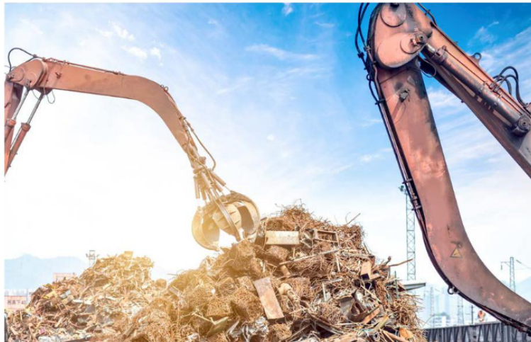
Chantier de déconstruction, où l'on récupère des matériaux comme de la ferraille ou des gravats - © onlyyouq/freepik
